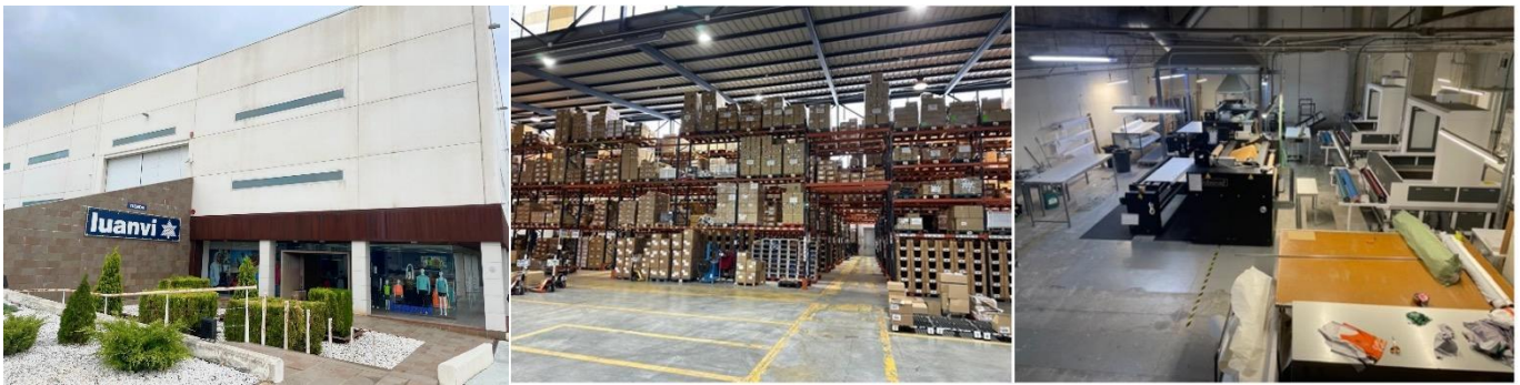
Immeuble acquis par Novaxia Investissement pour le compte de la SCPI Novaxia NEO à Valence, Espagne
